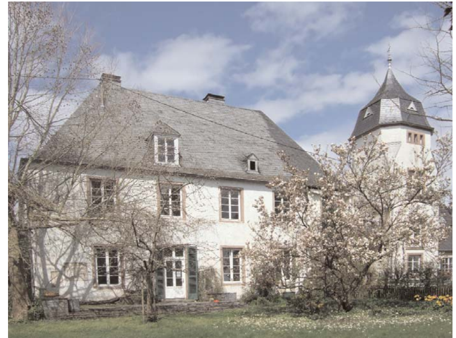
Gartenseite, rechts der Turm von 1906
